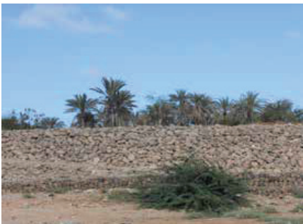
Doc 5 : Digue d'Ambouli
